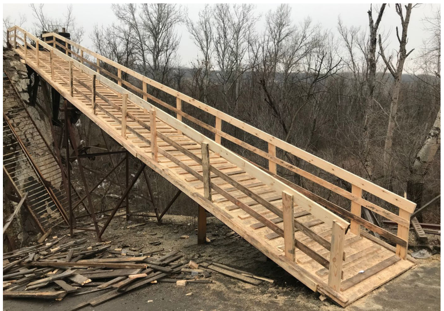
Die Stanytsia-Luhanska-Brücke, die derzeit repariert wird, ist die einzige Fussgängerverbindung zwischen dem Regierungsgebiet und den abtrünnigen Gebieten der Region Luhansk. IKRK
