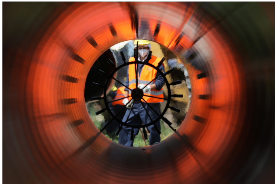
Des ouvriers vus à travers un tuyau sur un site de construction de l'extension du gazoduc russe TurkStream en Bulgarie, en juin 2020. Stoyan Nenov / Reuters
