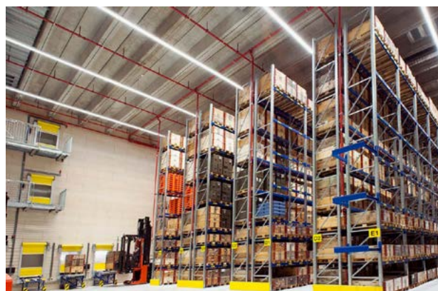
Schmalganglager, wie sie in der privaten Logistik Standard sind, werden auch in der LBA verwendet. In allen fünf Armeelogistikcentern steht eines im Einsatz / oder noch im Bau. Hier das SGL im ALC Othmarsingen. (VBS/DDPS)
